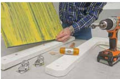
**14.** Um die Gegenbohrungen in der Plattenkante zu markieren, „Dübelifix“ in die Dübellöcher der Seitenteile stecken und die Position der Dübel auf die Kanten der Ablagen übertragen. Die Gegenbohrungen vornehmen. Leim angeben und mit Zwingen fixieren, bis der Leim trocken ist.
