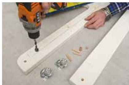
**13.** Mit einem 6er-Bohrer mindestens drei Löcher in halber Dübellänge bohren. Ein Tiefenanschlag oder ein um den Bohrer fixiertes Kleband garantieren die passende Bohrtiefe.
