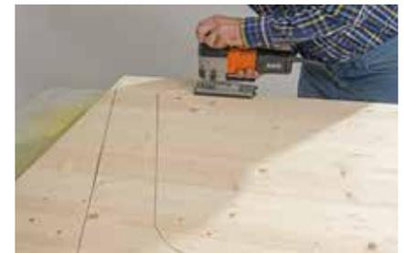
**6.** Aus Pappe die Schablone eines Seitenteils fertigen und die Maße an Ihrem Bett überprüfen. Die Kontur übertragen und mit der Stichsäge zusägen. Das erste Seitenteil dann als Schablone für das zweite benutzen.
