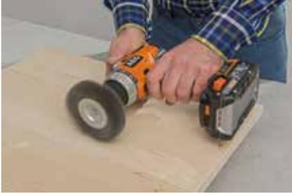
**1.** Für die zweifarbige Gestaltung der Ablagen müssen die Leimholzplatten mit einem Messing-Bürstenaufsatz bearbeitet werden (in Faserrichtung). Das härtere, dunklere Spätholz tritt hervor, und die natürliche Maserung wird deutlich sicht- und fühlbar.
