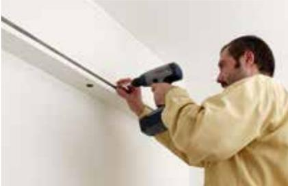
**7.** Laufleisten anbringen: Bohrlöcher markieren und Dübel einsetzen. Anschließend montieren Sie die Konsolen mit Schrauben (5 x 80).
