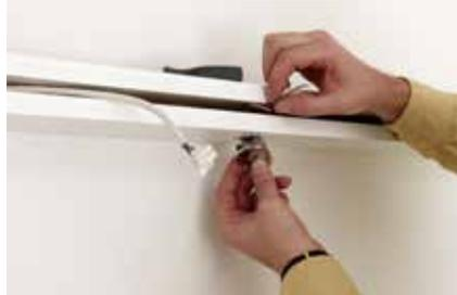
**8.** Verbinden Sie die Leuchten mit dem Stromkabel und drücken Sie sie in die vorbereiteten Löcher. Dann die Kabel mit je einer Zwischenleiste abdecken.
