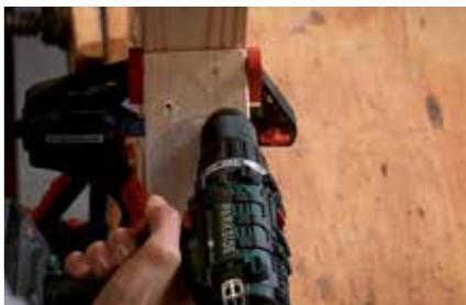
**10.** Die Verbindung von Fuß und Pfosten mit je zwei Querhölzern verstärken. Vorbohren, damit die Kanthölzer nicht reißen.
