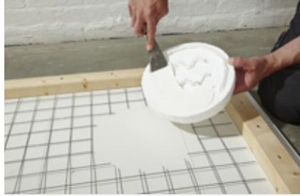
**11.** Mit für Styropor geeignetem Kleber die Styroporelemente auf die Platte kleben. Dazu das Armierungsgitter als „Schablone“ einlegen.
