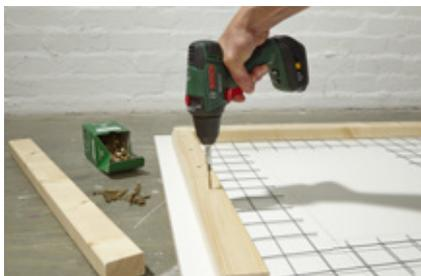
8. Die Dachlatten auf die Spanplatte schrauben. Das Armierungsgitter probeweise einlegen.
