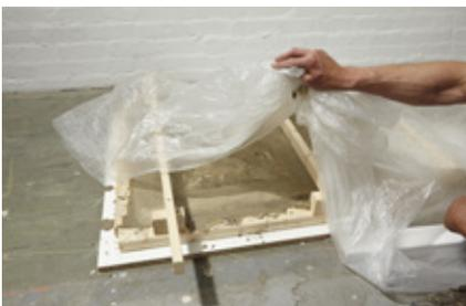
25. Der Beton muss mit dem Anmischwasser reagieren und darf daher nicht austrocknen. Während des Aushärtens mit Folie abdecken...
