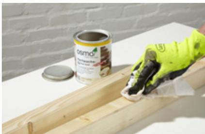
7. Die Dachlatten, die als Schalungslatten dienen, mit Hartwachsöl behandeln, damit sich die Arbeitsplatte später gut ablösen lässt.
