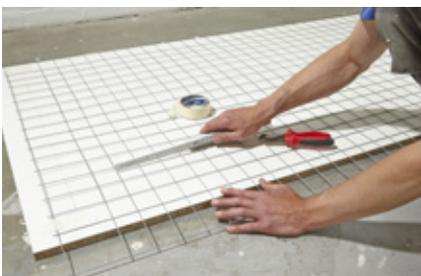
5. Das Armierereisen entsprechend der Maße der Arbeitsplatte zuschneiden. Es sollte umlaufend etwa einen Zentimeter kleiner als die Platte sein.
