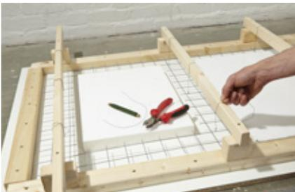
**13.** Jetzt das Armierungsgitter positionieren. Es soll die Arbeitsplatte später in deren Kern stabilisieren. Das Gitter wird daher an Drähten hängend etwa 2 cm über der Spanplatte positioniert.
