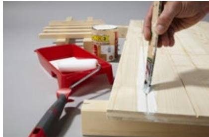
**11.** Trocknen und zwischenschleifen (mit 240er-Körnung). Grundierung auftragen.
