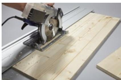
**4.** Die Eintauchtiefe der Kreissäge auf drei bis vier Millimeter einstellen und mit Führungsschiene die Nuten sägen.
