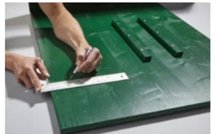
**15.** Damit die Böden nicht durchhängen, werden auch an der Rückwand Leisten angebracht. Die Position des Bodens anzeichnen.
