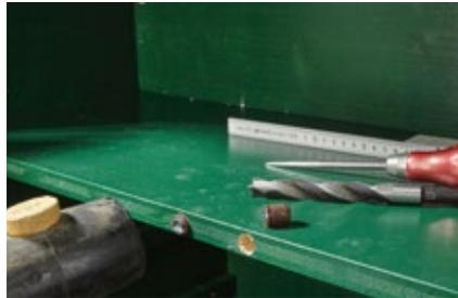
**20.** Die Magnetverschlüsse, je nach Modell, einbohren oder aufschrauben.
