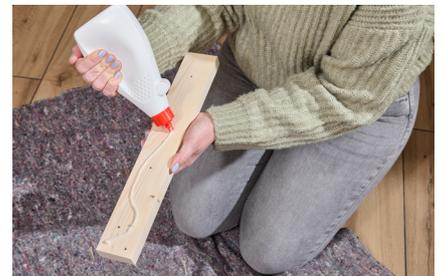
**6. An eines der vorgebohrten,** schmalen Konstruktionshölzer einseitig Leim angeben.
