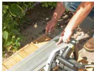
**14.** Sind alle Dielen verschraubt, werden die Ränder gerade abgeschnitten. Markieren Sie mithilfe einer Schnur eine gerade Kante.
