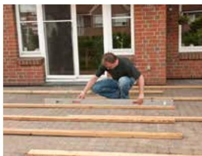
2. Legen Sie die Lagerhölzer mit etwa 50 cm Abstand aus. Mit einer Richtlatte können Sie prüfen, ob sie in einer Ebene liegen.
