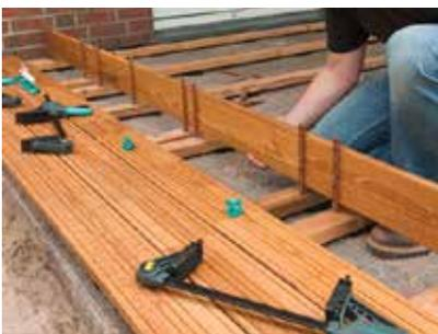
**9.** Die speziellen Verbinder aus Kunststoff werden von unten an die Dielen verschraubt. Gleichzeitig sind die beiden Holzlagen entkoppelt, und Luft kann zirkulieren.
