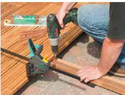
**10.** Am Überstand lassen sich die Verbinder mit den Lagerhölzern verschrauben. Die klassische Alternative: von oben sichtbare Edelstahlschrauben.
