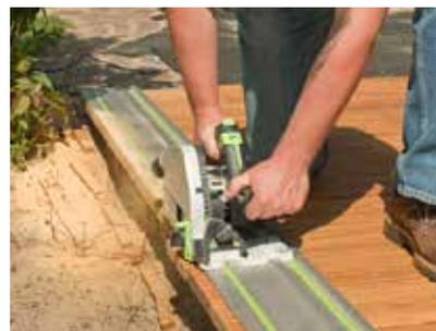
**15.** Einen exakten Randabschluss liefert eine Handkreissäge, die Sie an einer Schiene entlangführen. Wenn gewünscht, die Stirnseiten noch mit einer Holzdielen verblenden – fertig.
